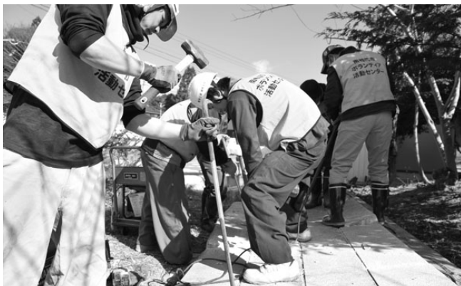
塀の撤去作業中の様子。
